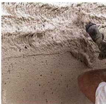
Fixit 222 Aerogel, mélange de chaux hydraulique et d'aérogel de silicate, se présente sous forme d'enduit minéral. Sa conductivité thermique est égale à 0,028 W/(m.K) et sa masse volumique à sec à 220 kg/m 3 . Ouvert à la diffusion de vapeur d'eau, il permet de reconstituer des maçonneries fidèles à l'original.
