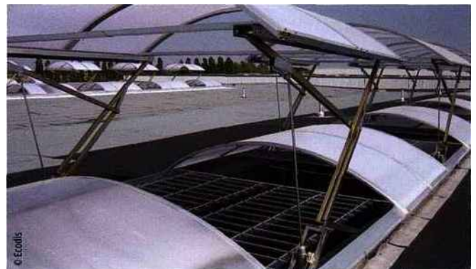
Les lanterneaux offrent une pénétration diffuse et une distribution homogène de la lumière naturelle dans un bâtiment.
