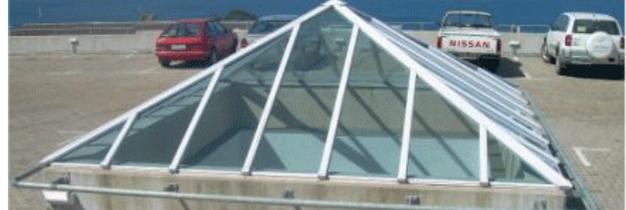
VERRIERE D'ÉCLAIREMENT EN VERRE À RUPTURE DE PONT THERMIQUE
