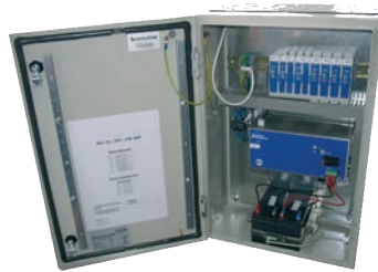
Centrale MZ2 , de 16 A à 144 A
