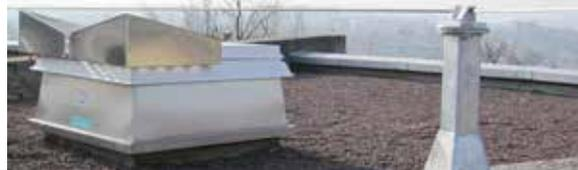
EXUTOIRE DE FUMÉES PNEUMATIQUE À RUPTURE DE PONT THERMIQUE
