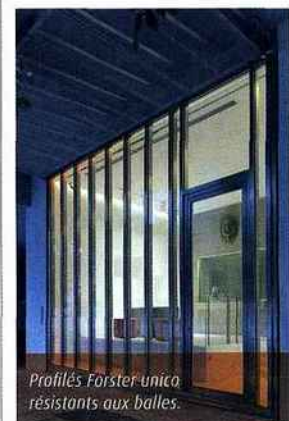
Porte Forster unico, système anti-pince-doigts.
