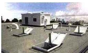
Composé d'un dormant et d'un ouvrant alu avec doubles rupteurs en polyamide, et d'une costière acier galvanisé de 40 cm de haut avec isolation en laine de roche de 50 mm d'épaisseur. Ouverture de l'ouvrant via 2 verins pneumatiques dotés d'amortisseurs de fin de course. Étanchéité par joints EDPM. Disponible avec capot alu de 32 mm d'épaisseur ou en polycarbonate alvéolaire de 16 à 32 mm d'épaisseur.
