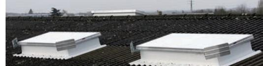
EXUTOIRE DE FUMÉES MÉCANIQUE POUR COUVERTURE SÈCHE
